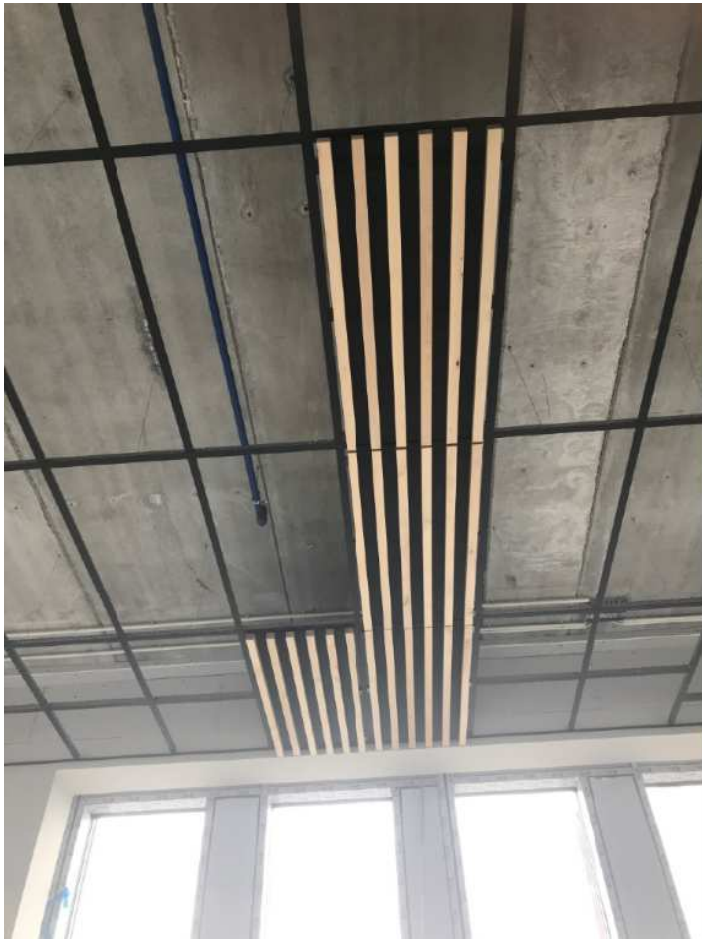
Påbegynt spilehimling i beredskapsrom 2. et.
